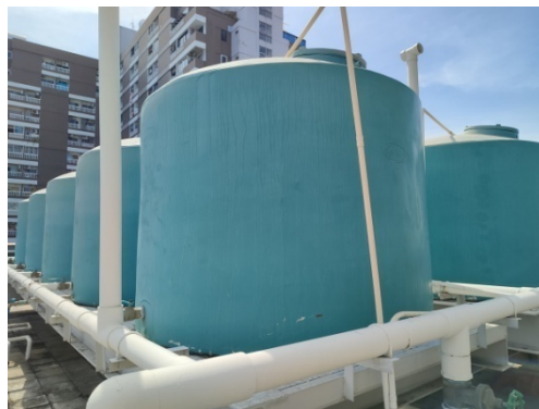
ภาพที่ 4-8 ถังสำรองน้ำขึ้นดาดฟ้า
